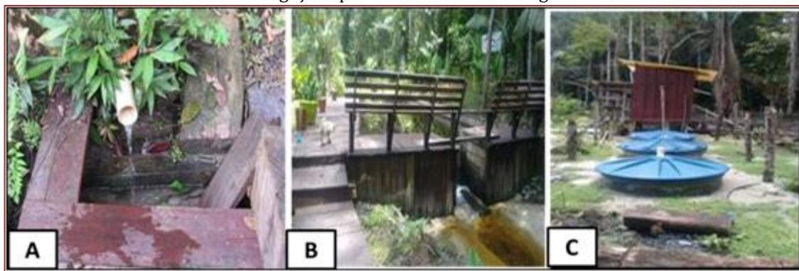
No caso A, os moradores aproveitam a percolação natural, por gravidade, da água do talude que faz limite da propriedade no qual foi inserido um cano de PVC de 50mm onde ocorre o escoamento. No local é captada a água para dessedentação da família e utilização para alimentação.
