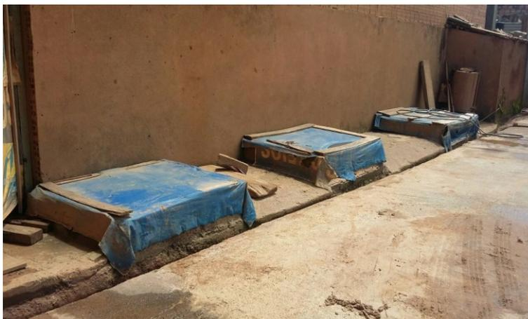
**Figura 1:** Caixas separadoras de água e óleo em um empreendimento de lavagem de veículos no município de Jaru. **Fonte:** Faria, M. L. C. (2015).
