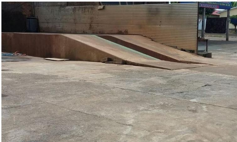
**Figura 2:** Estrutura e piso impermeável em um empreendimento de lavagem de veículos no município de Jaru.
